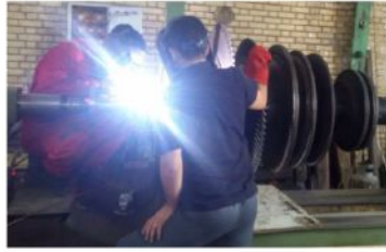
پروژه: تعمیر نشیمنگاه لیبرنس های توربین ۴/۷ مگاوات کارفرما: پالایشگاه سازند اراک
