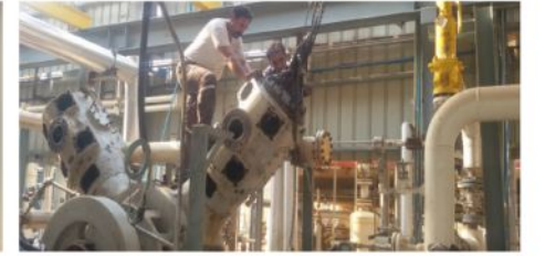
پروژه: رایدر رینگ و پیستون رینگ کارفرما: پتروشیمی تخت جمشید
