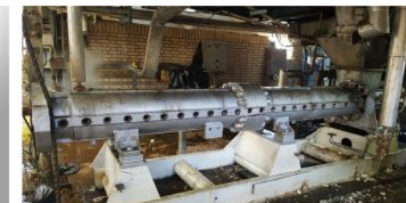
پروژه : ساخت قطعات اکسیژن درایر کارفرما : پتروشیمی تخت جمشید
